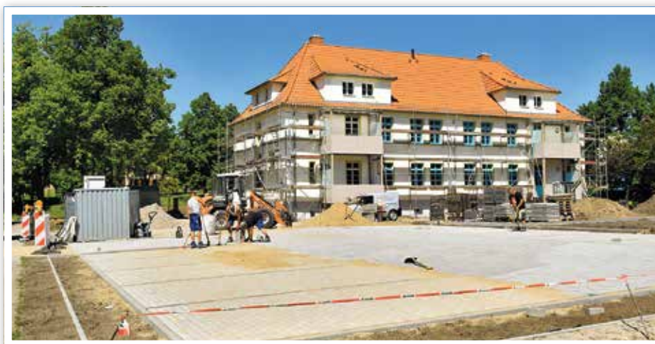
Mit der Sanierung der Stadtvilla einher gehen auch die Außenarbeiten. Hier entstehen neben den Mietergärten auch Pkw-Stellplätze.
