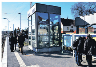
Neuer Bahnsteig mit Aufzug
