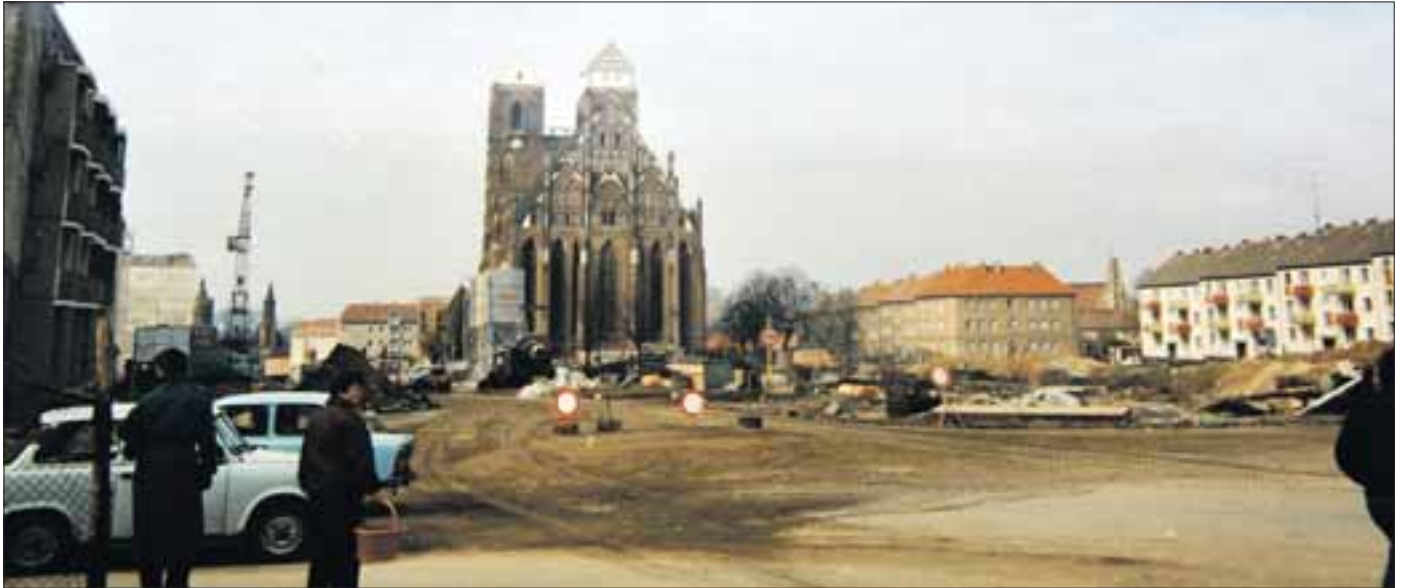
Die Großbaustelle auf dem Marktberg, dem damaligen Ernst-Thälmann-Platz, 1988.
