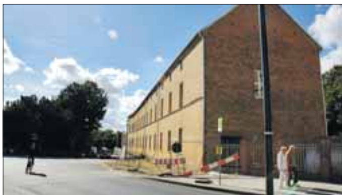
Aufträge für das WIGA-Gebäude gingen unter anderem an den Bauhof Haßleben, die Gramzower Wohn- und Geschäftsbau und Elektro-Gottschalk.
