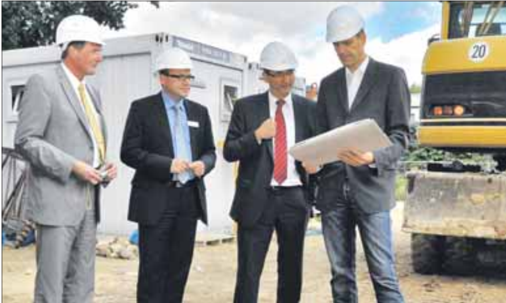
Im September besuchte Ministerpräsident Matthias Platzeck die Wohnbau GmbH und informierte sich unter anderem über das Bauvorhaben Schwedter Straße 25 bis 29.
