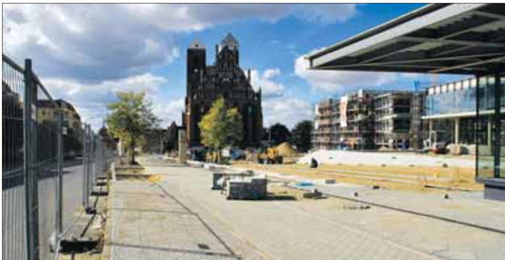
Für die Freiflächen auf dem Marktberg haben die Gartzter Straßen- und Tiefbau GmbH sowie die Firma Elektro-Gottschalk einen Zuschlag erhalten.
