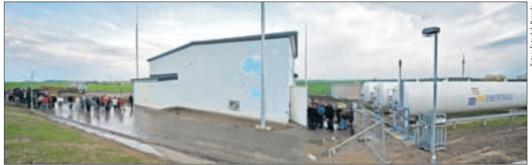
Das Interesse am Enertrag-Hybridkraftwerk und der Wasserstofftechnologie war mit rund 500 Gästen deutlich.
